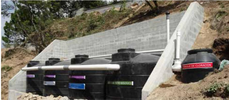
CON TANQUES DE POLIETILENO DE ALTA DENSIDAD
