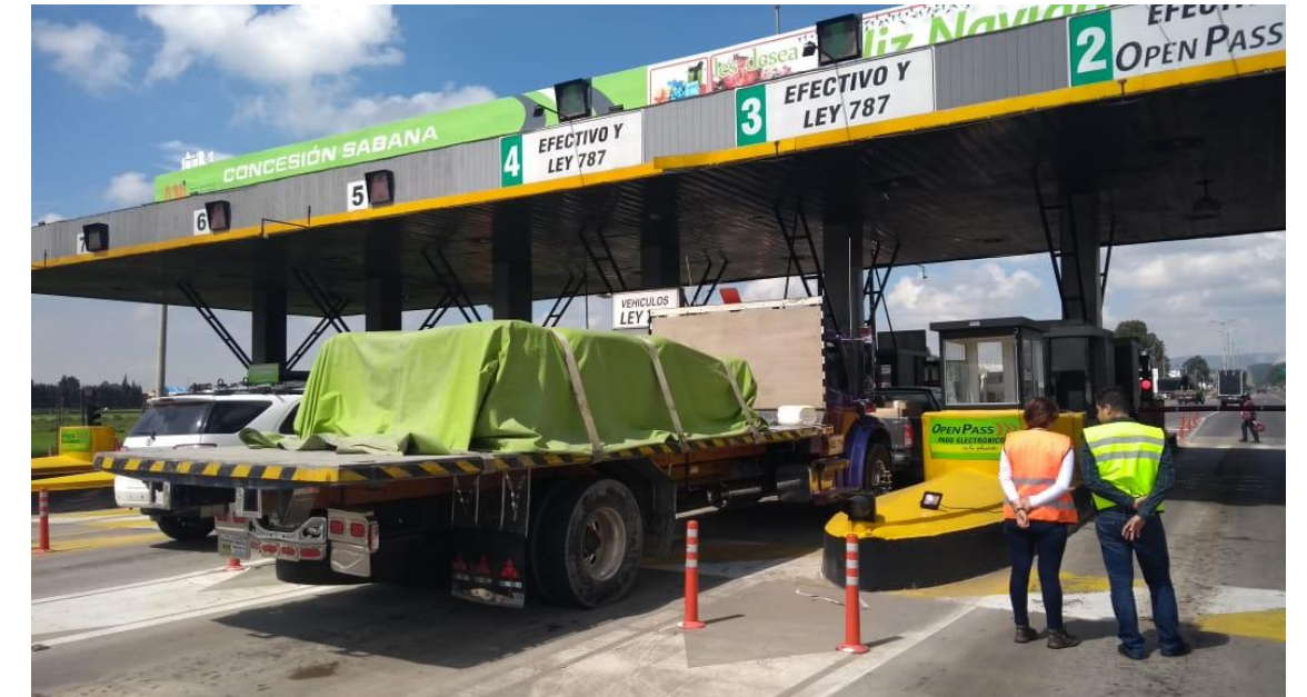
INSTALACIÓN SUBSISTEMAS DE COMUNICACIÓN, CONTROL, Y FUERZA - PEAJE SIBERIA
