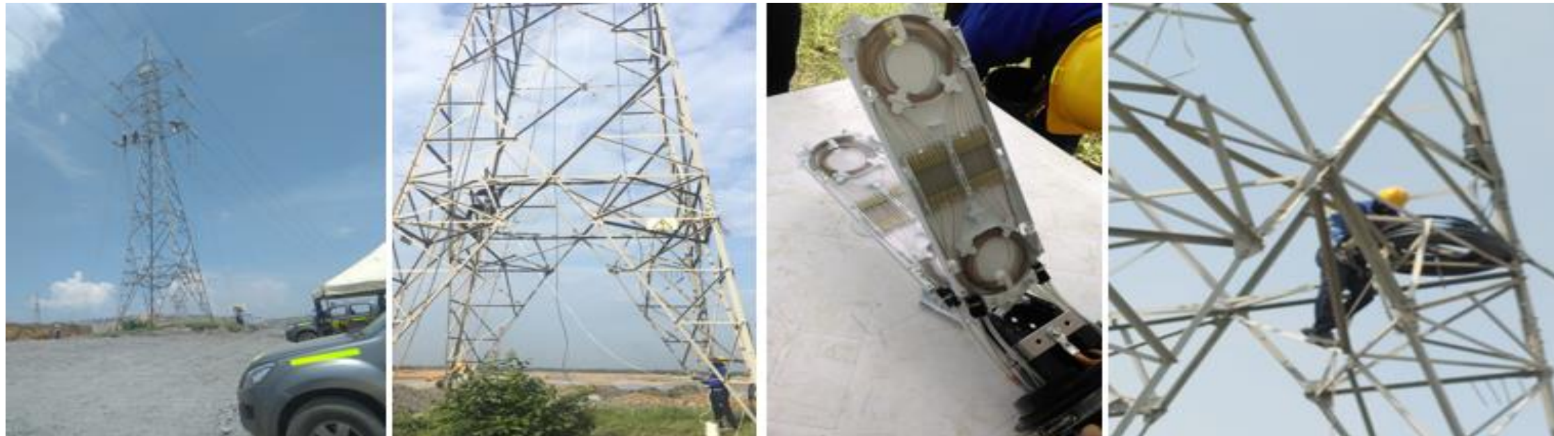
TENDIDO DE MÁS DE 100 KMS DE F.O. EN TORRES DE 115KV
