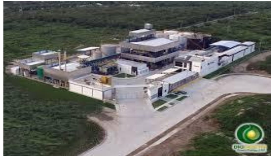
AUTOMATIZACION PLANTA DE BIODIESEL
