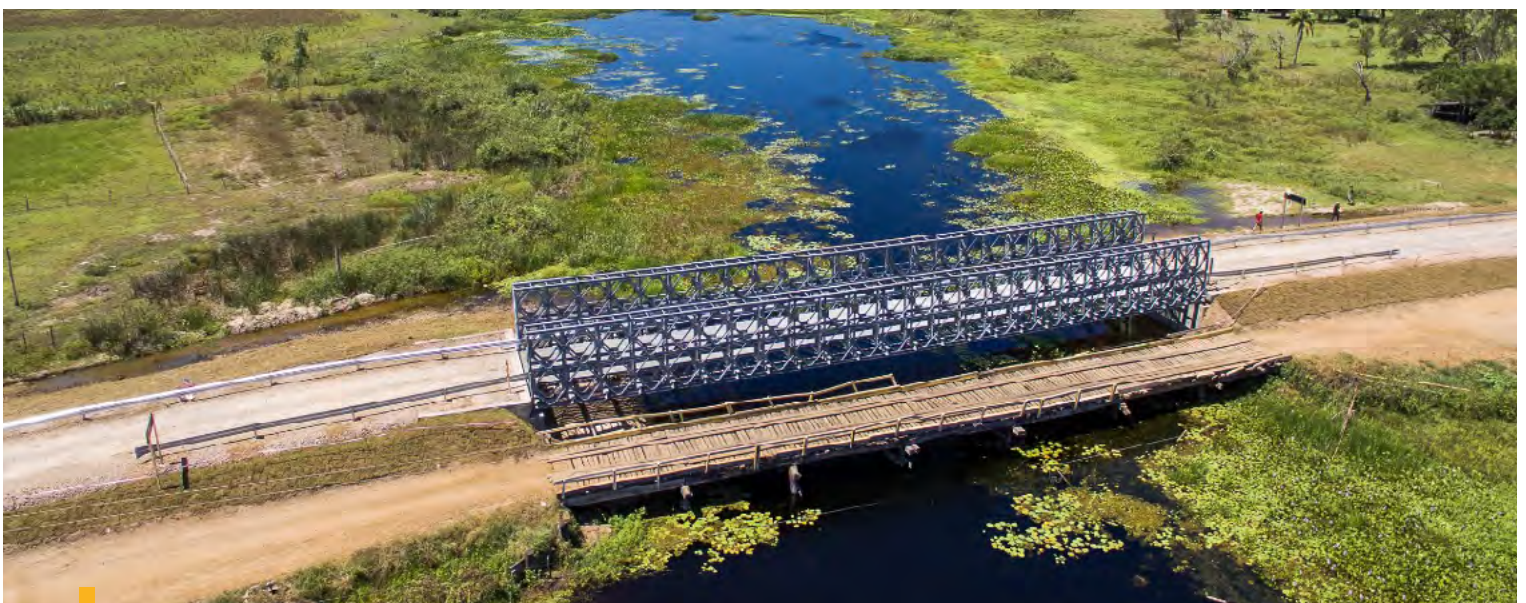
Puente Arroyo Yakaré | Obra Pilar Alberdi
