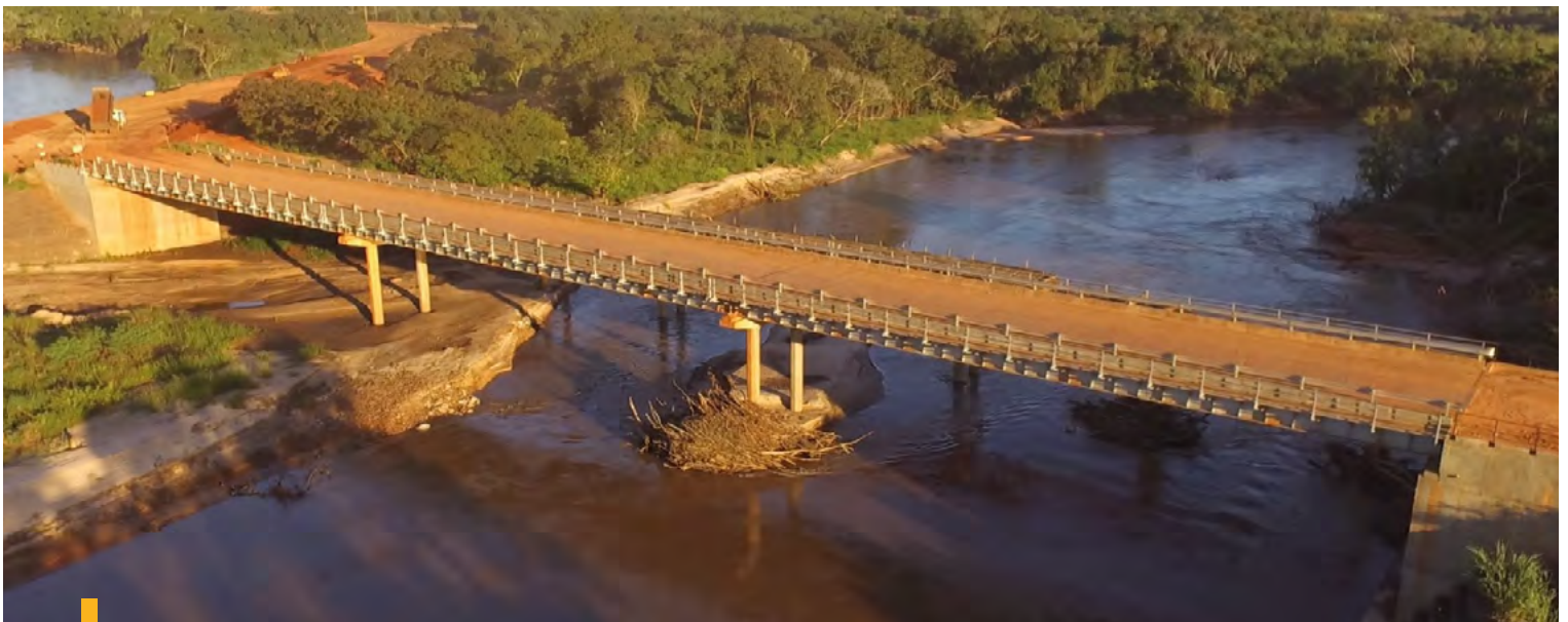
Construcción de puente mixto sobre el Río Ypane, tramo Tacuati - Horqueta
