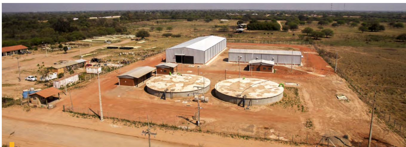
Construcción de aductoras, centro de distribución y estaciones de bombeo en el Chaco Central
