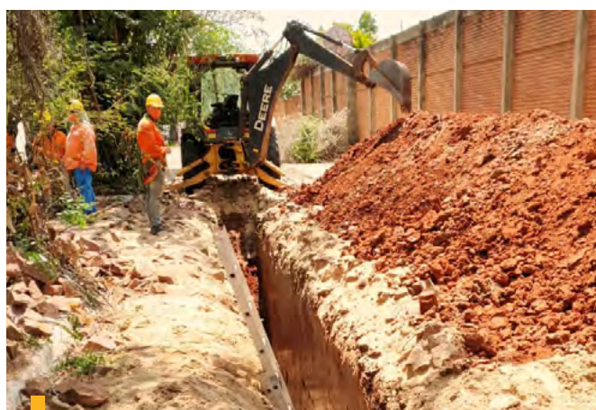
Construcción de colectores secundarios de alcantarillado sanitario para la ciudad de Fernando de la Mora
