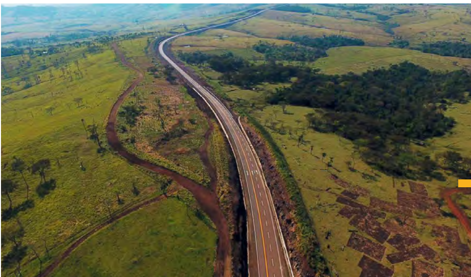
Rehabilitación y pavimentación del Tramo Santa Rosa del Aguaray - Capitán Bado, Obra 4: Colonia Piray Km. 105 - Km. 138,65 Capitán Bado. Travesía urbana (37,28 km)
