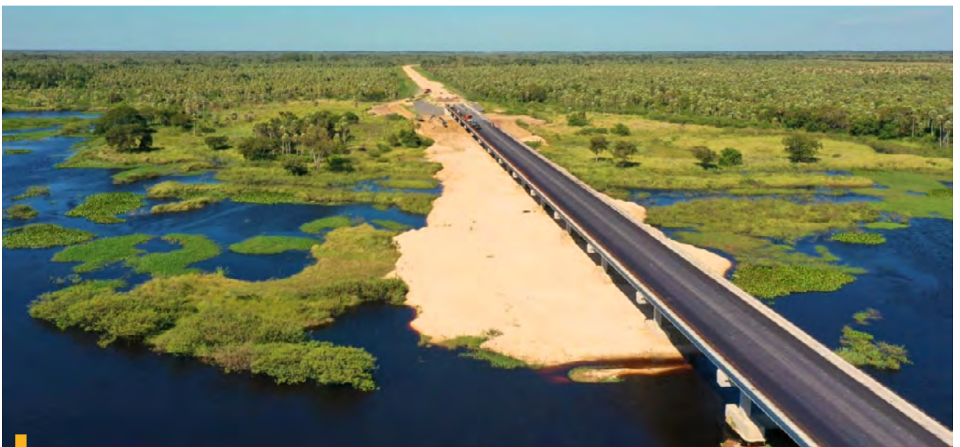
Puente sobre Arroyo Yakaré | Obra Rehabilitación del tramo desvío Alberdi - Pilar. Obra 2: Río Tebicuary - Pilar y Acceso ciudad de Pilar
