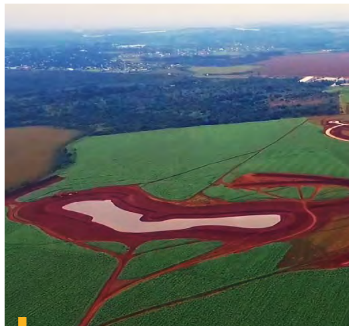
Construcción de la Crystal Lagoon Hernandarias
