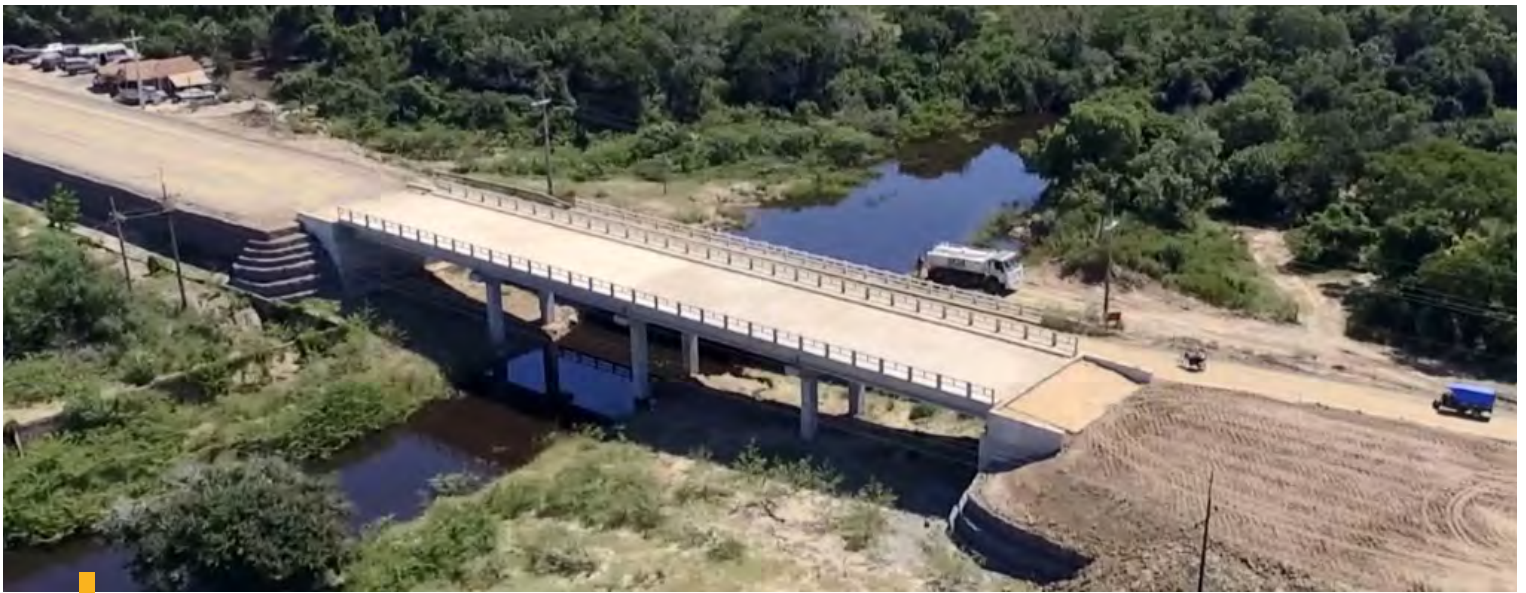
Puente sobre Arroyo Montuoso - Obra Rehabilitación del tramo desvío Alberdi - Pilar. Obra 2: Río Tebicuary - Pilar y Acceso ciudad de Pilar
