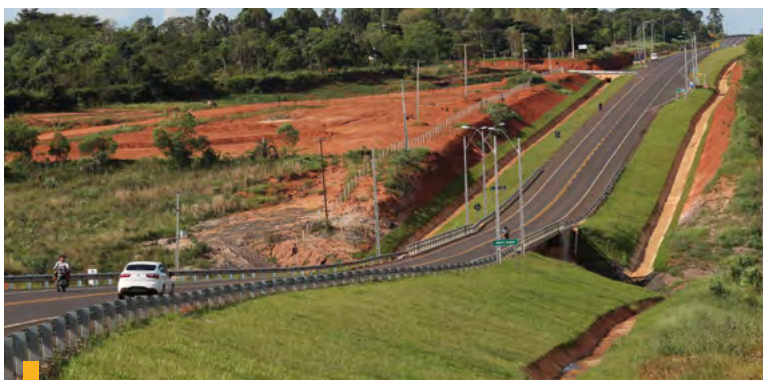
Rehabilitación y Pavimentación del Tramo: Caaguazú - Vaqueria Seccion I y II
