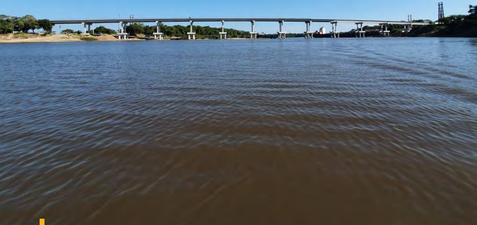
Puente sobre Río Tebicuary | Obra Rehabilitación del tramo desvío Alberdi | Pilar. Obra 2: Río Tebicuary - Pilar y Acceso ciudad de Pilar
