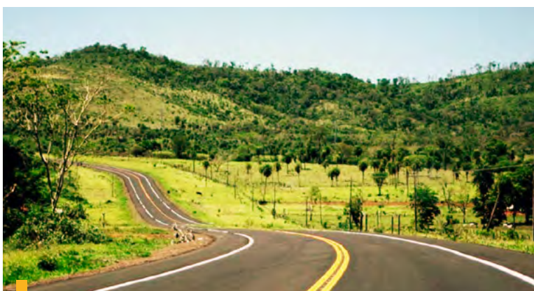
Recapado de la Ruta N° 5 "Gral. Bernardino Caballero", Tramo: Yby yau - Km. 179
