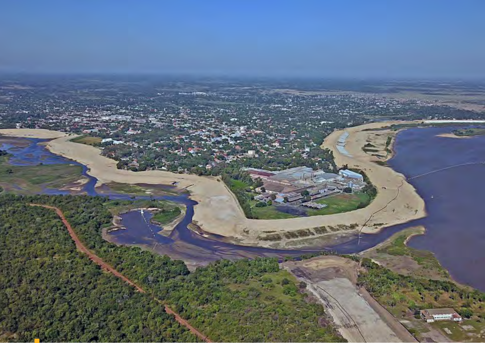
Construcción de ampliación de la franja costera de Pilar, departamento de Ñeembucú
