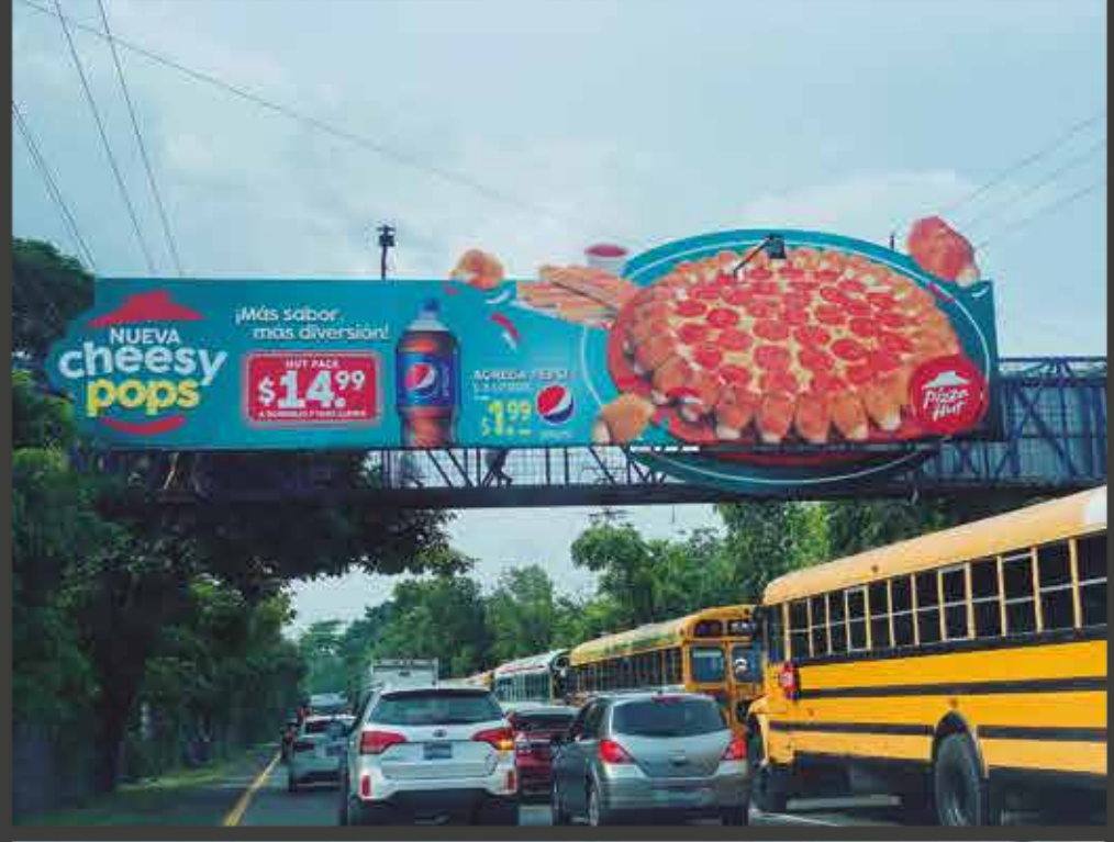
Estructura metalica y lona tensada Cliente: MOP
