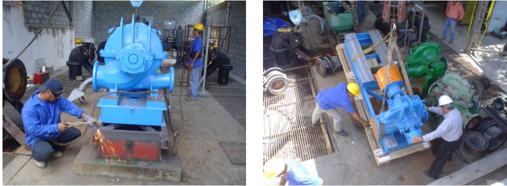
Instalación de Equipo Nuevo – Estación de Bombeo Miraflores
