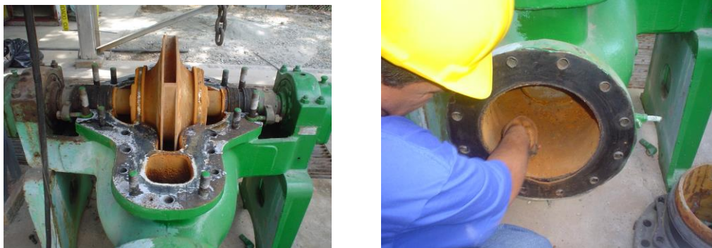
Mantenimiento de Equipo Existente – Estación de Bombeo Miraflores
