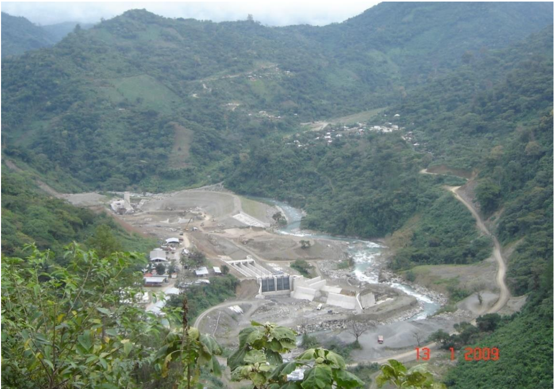
Instalaciones de drenajes, subdrenajes, agua de servicio aire comprimido , Agua potable en Casa de Máquinas y Embalse. Solel Boneh Int. Guatemala
