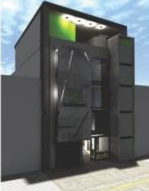
CONSTRUIDO RESERVA CANAVERAL Cañaveral cerca de la facultad de medicina de la UNAB
