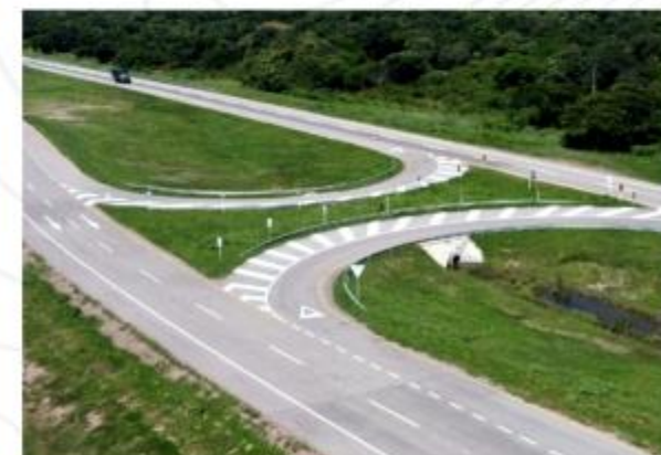
Ruta del Sol sector III Empresa - Constructora Ariguani
