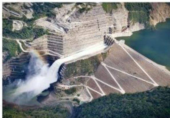
Proyecto Hidroeléctrico Ituango Empresa CCC ITUANGO
