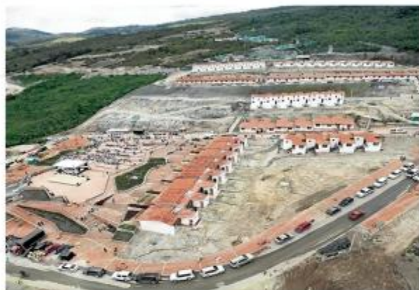
Reconstrucción nuevo Gramalote Empresa CONCVILES
