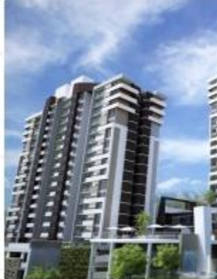
CONSTRUIDO belmare Cañaveral cerca de la facultad de medicina de la UNAB
