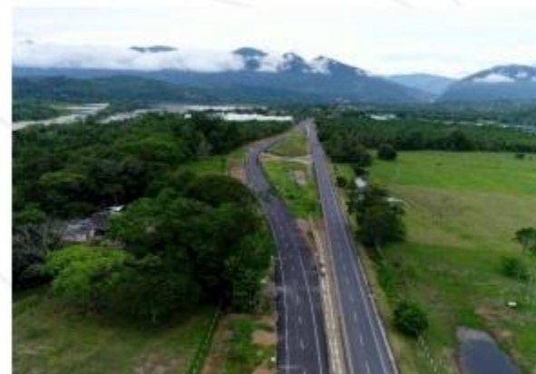
Doble Calzada Bucaramanga - Barrancabermeja Empresa Consorcio Ruta del Cacao - Ferrovial
