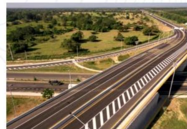
Doble calzada Puerta de Hierro - Palmar de Varela - Ruta del Sol Empresa SACYR CONSTRUCCIÓN S.A.S
