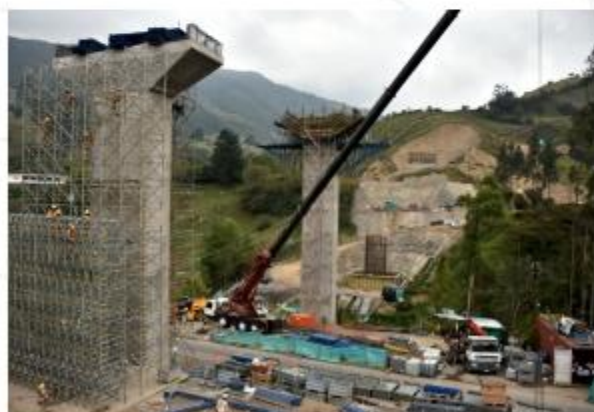
Doble Calzada Pamplona - Cucuta Empresa Consorcio Pacu - Sacyr Construcción Colombia S.A.S
