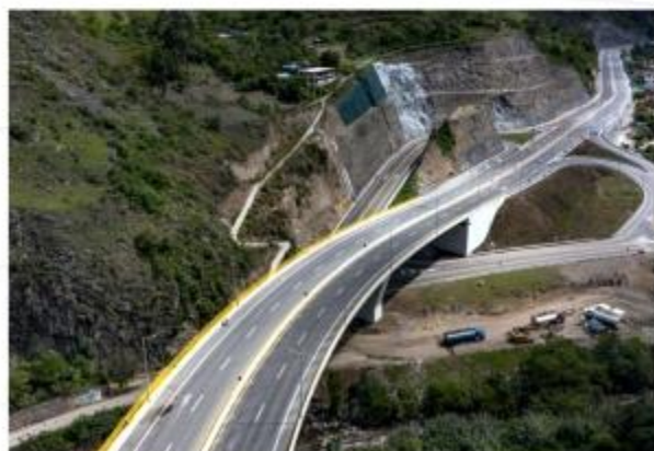
Doble calzada Pasto - Rumichaca Consorcio SH - Sacyr construcción S.A.S y Herdolza Crespo Construcciones.
