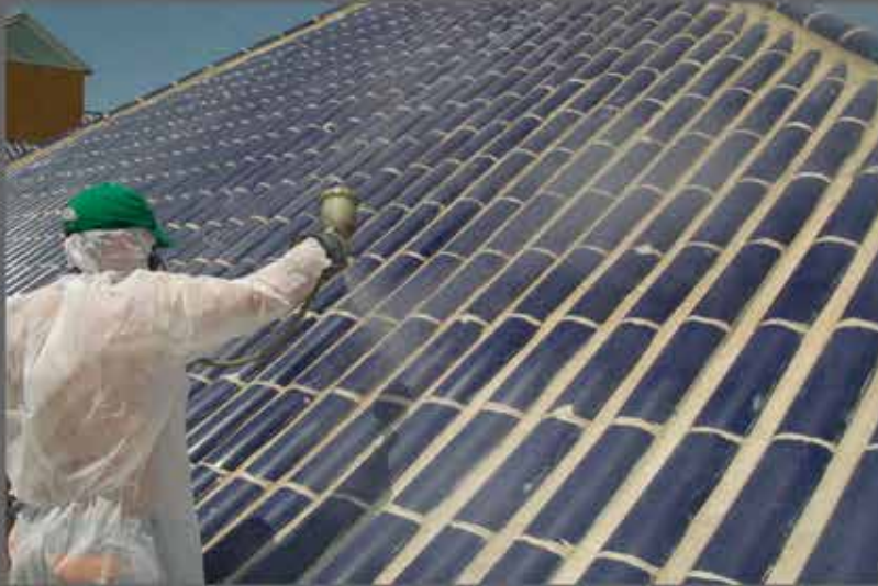
Impermeabilización de techos
