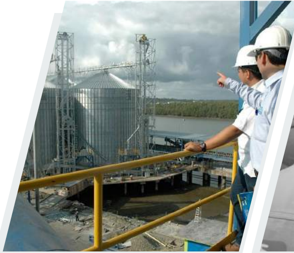
Instalación y Supervisión
