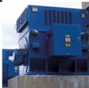
TRANSFORMADORES DE ENERGÍA
