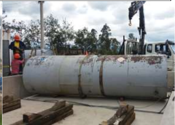
Montaje de tanques de combustible
