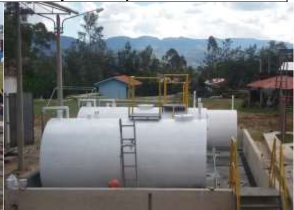
Acabado final de los tanques
