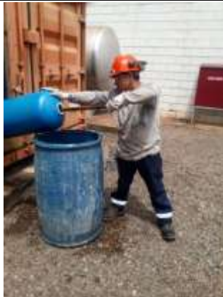
Mantenimiento de filtros de grava, carbon activado e intercambio ionico
