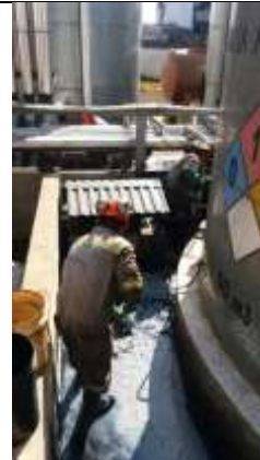
Limpieza de área de tanques
