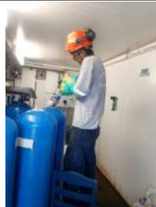
Relleno con nuevos materiales filtrantes
