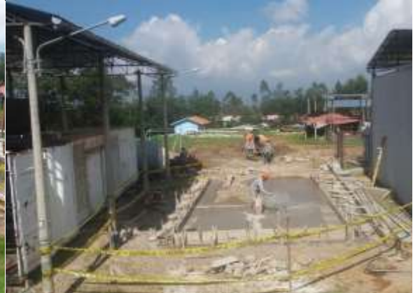
Loza de concreto armado construida
