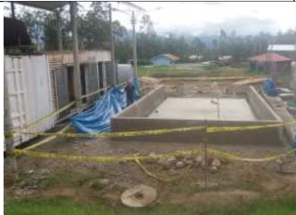
Dique de contencion construido
